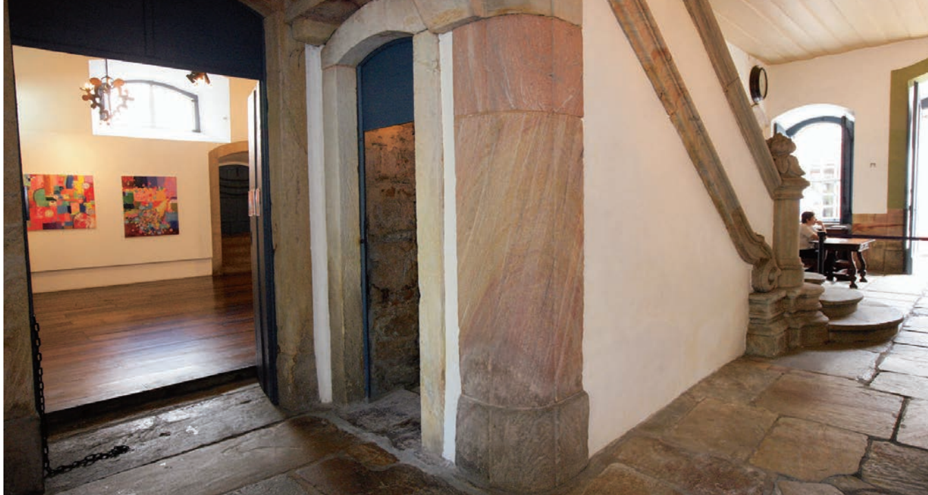
Vão sob a escadaria monumental e à esquerda porta de acesso à cela de Cláudio Manoel da Costa que ficou emparedada por décadas e reaberta na restauração de 1993/4 - Foto: Neno Vianna
