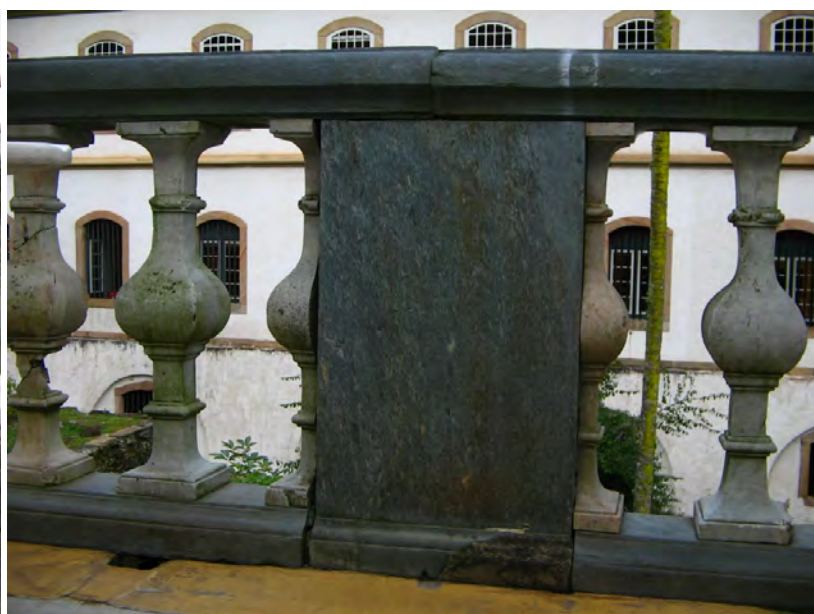
Cunhal interno – Ouro Preto
