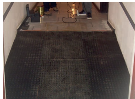
Construção de rampa
