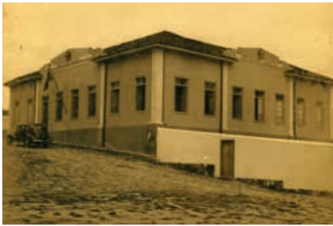
1943 Antigo prédio da prefeitura de Salinas
