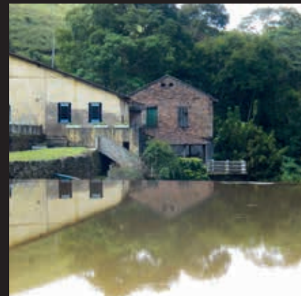
Instalações da antiga Fábrica de Coalho Frísia
