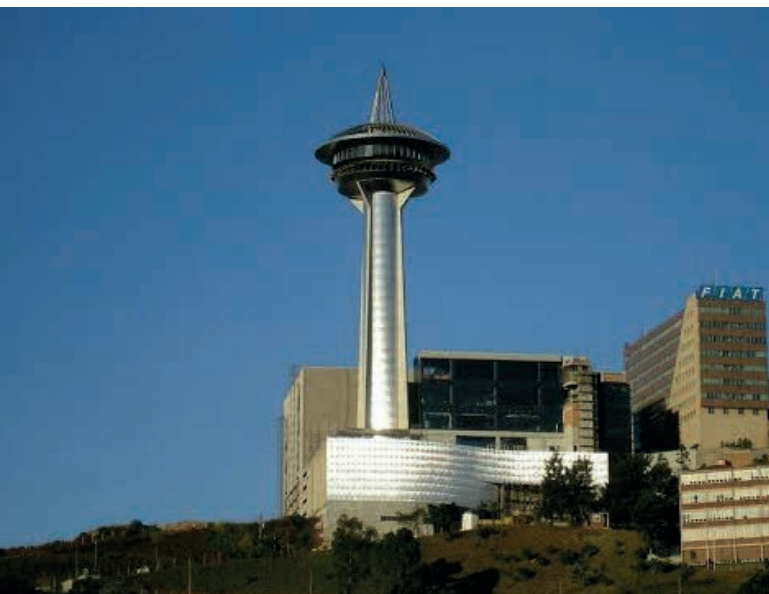
Torre Alta Vila
