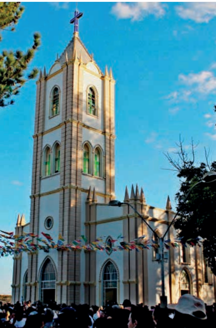
IGREJA MATRIZ DE NOSSA SENHORA DO ROSÁRIO Foi construída na década de 1960
