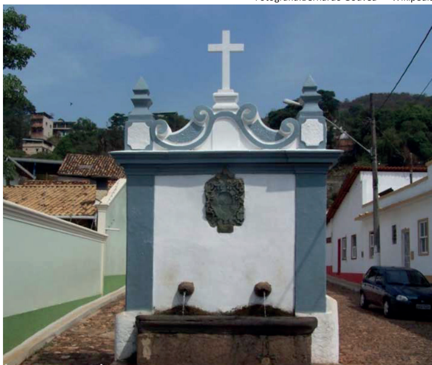
Chafariz do Kaquende está localizado na rua da República, em Sabará MG
