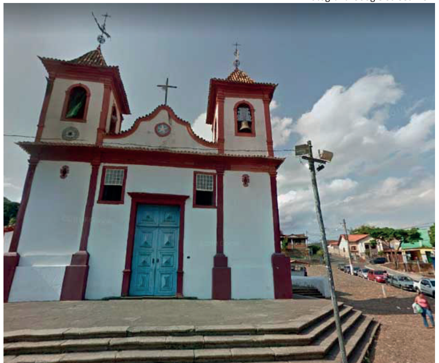
A igreja está localizada na Praça Getúlio Vargas no centro de Sabará, MG. Popularmente conhecida por “Igreja Nova” ou “Grande”, a igreja ganhou esses apelidos por substituir uma capela no mesmo local. Contudo, apesar da denominação, tem documentos que datam sua construção em 1718.
